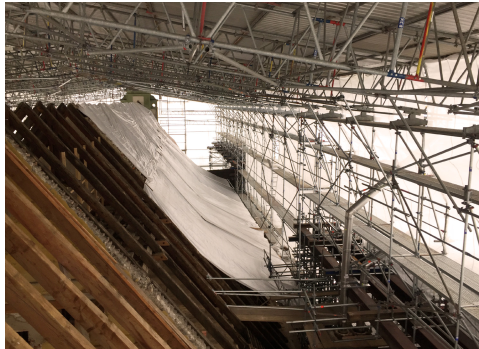
BLICK AUF DIE SANIERUNGSARBEITEN AM DACHSTUHL DES ASAMGEBÄUDES
