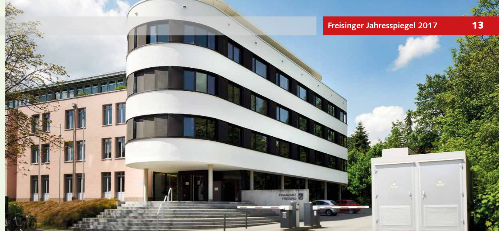
Allseits gerundet: Der Gestaltungsbeirat begleitete im Jahr 2009 die Planung für die Erweiterung des Finanzamts Freising an der Alois-Steinecker-Straße.
