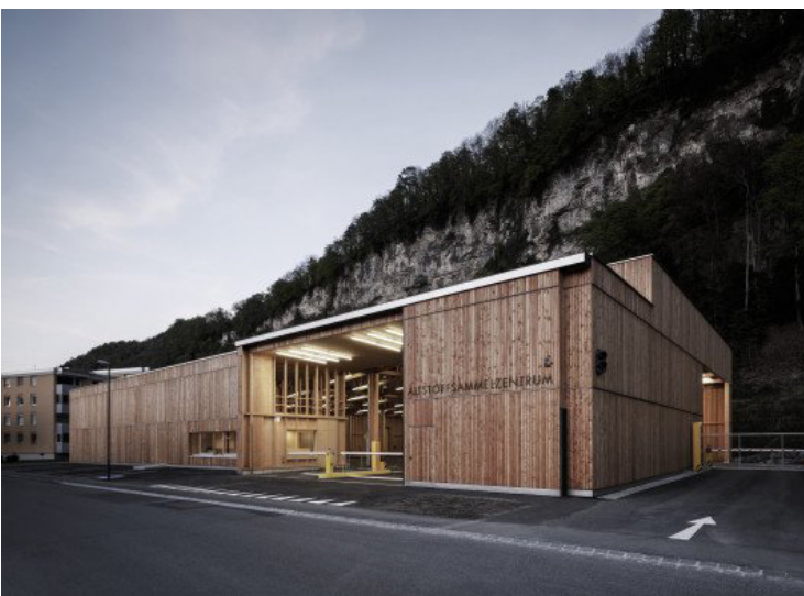
Altstoffsammelstelle von Marte.Marte in Feldkich, Vorarlberg unter https://www.architektur-aktuell.at/projekte/marte-marte-altstoffsammelzentrum-feldkirch-eine-kathedrale-fuer-den-muell
