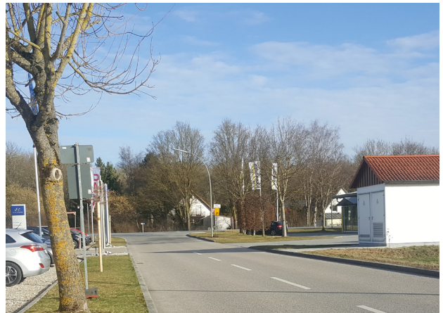
Foto 2: Bei neu angelegten Straßen fehlen Gehwege
