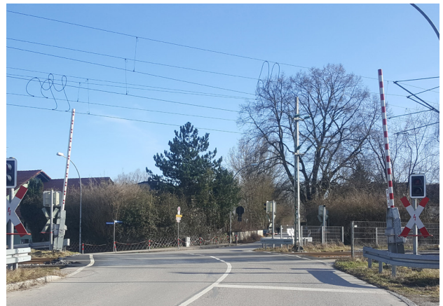
Foto 4 Bahnübergang im Ort
