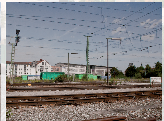
*1 Brachfläche am Bahnhof
