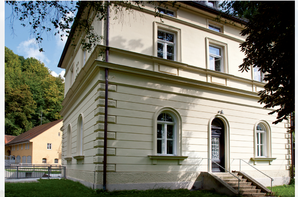
historisches Elektrizitätswerk an der Moosach
