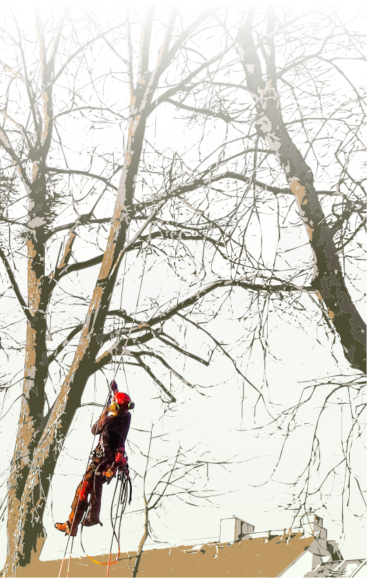
Sanierungsmaßnahme in der Baumkrone
